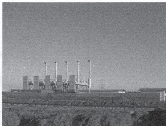
Fotografia 3.11 – Central eléctrica de Luena
