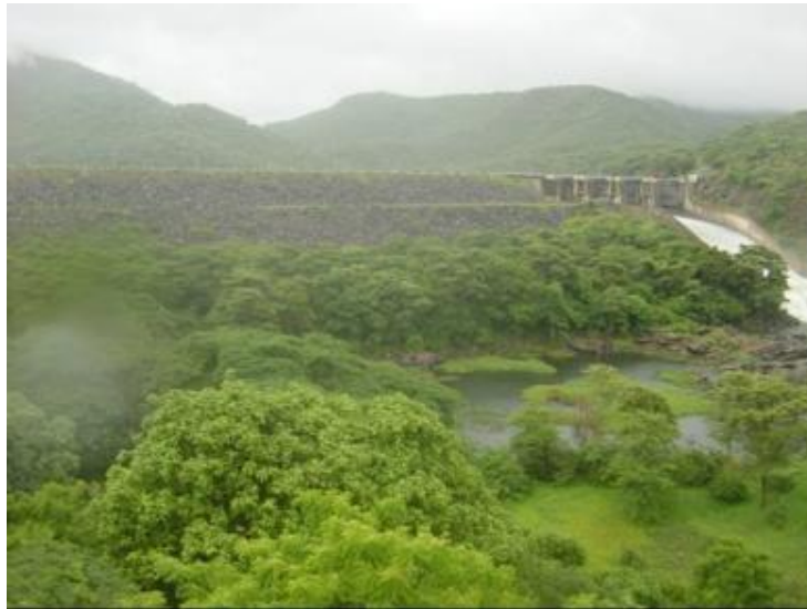
Figure 0.10 Kafue Gorge Dam (photo)
